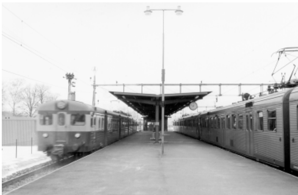
En bild från Rotebro 1970. Tåg mot Märsta utgörs av X6-motorvagnar och tåg mot Södertälje av X1. Foto Spårvägmuseum.
