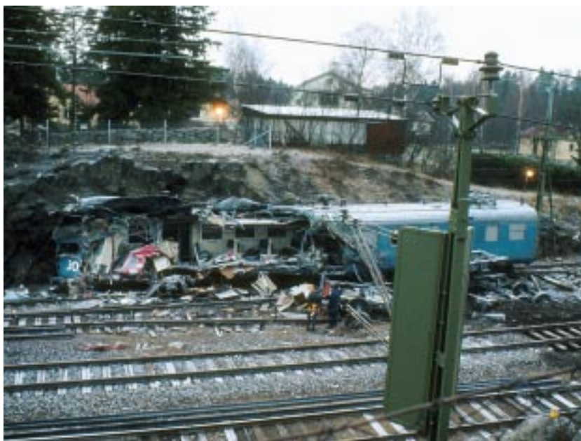
A-delen till X1 3059 skadades så svårt vid olyckan i Järna att den slopades. Bilden togs den 10 december 1972 då uppröjningsarbetet pågick. Foto Jan Lindahl.
