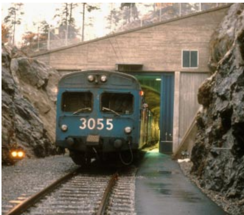
NEDAN: För att komma till rätta med en del av vinterproblemen, byggdes en särskild avisningshall i Älvsjö. Den sprängdes in i berget bakom verkstaden. Foto (samtliga) Jan Lindahl.
